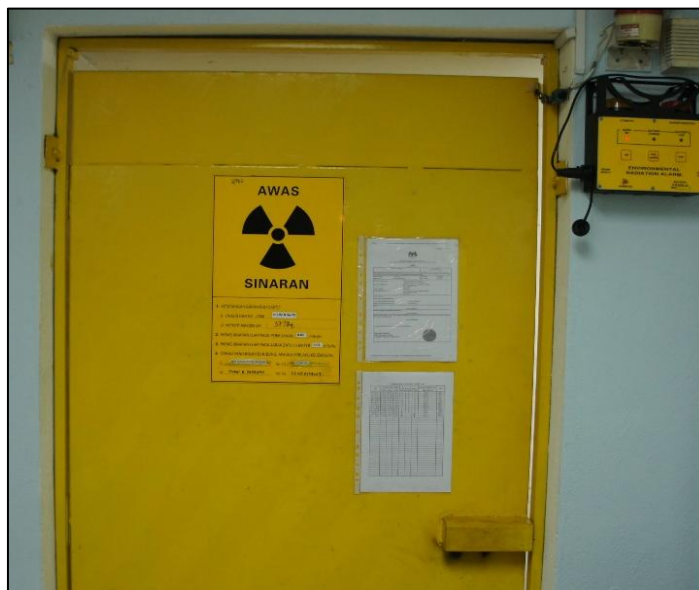
RAJAH 7: Contoh bilik penstoran bahan radioaktif dengan notis dan tanda amaran yang diletakkan pada pintu
