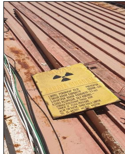
APK yang mengandungi bahan radioaktif tumbang dari pemasangan asal.
