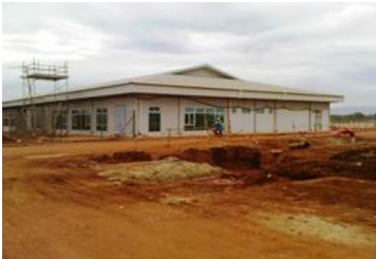
C7 – Bangunan Pentadbiran
